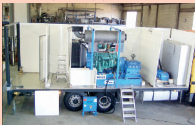
Mobiele installatie voor industriële reiniging in aanbouw. Nadat de geluidgedempte carrosserie deels is afgebouwd, wordt eerst een dieselmotor met hogedruk waterpomp (± 1500 bar) ingebouwd, evenals een RVS watertank en de benodigde leidingen. Pas hierna wordt de carrosserie verder afgebouwd.
